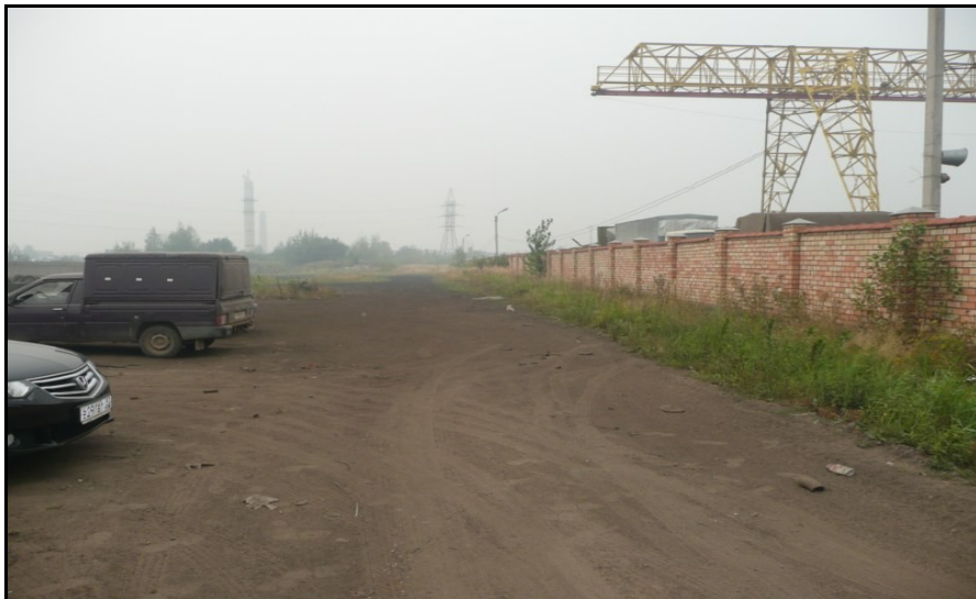
Второй объект: площадка 8209 м2 у ж/д ветки
